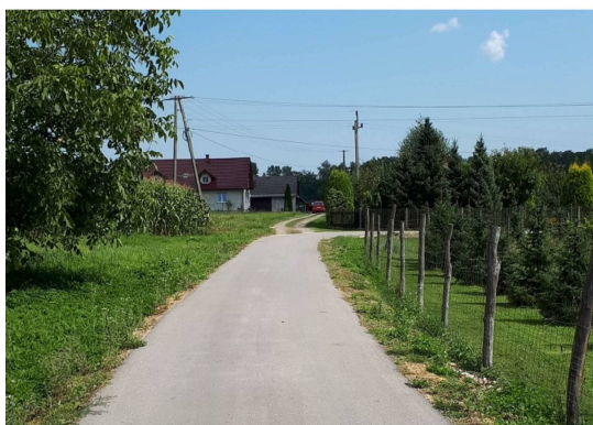
Gierałtowice ul. Dworska
